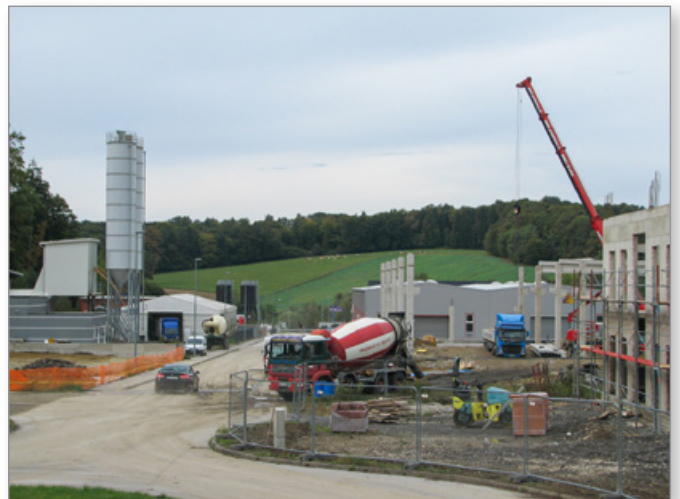
Potem ko je Poslovno-obrtna cona v Brengovi končno razprodana, je te dni tam, ob betonarni Gradbeništva Rokavec, prav živahno, na kar smo kar dolgo čakali. Foto: F. B.
