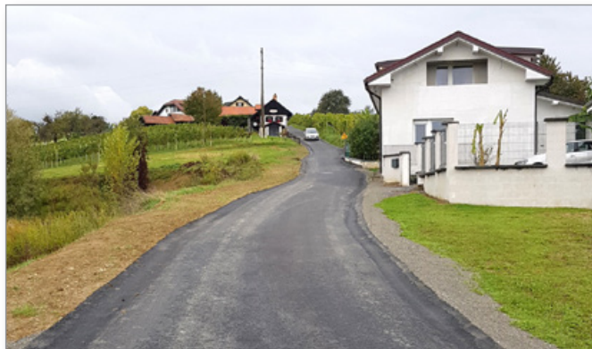
Preplastitev ceste v naselju Ivanjski Vrh
